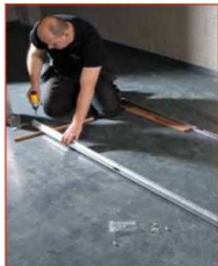
Připevněte hliníkový instalační U-profil na profil X40
