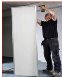
Přišroubujte nadpraží k zámkovému profilu samořezným
