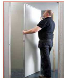
Dveře s rámem jsou připraveny k zabudování do stěny
