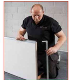
Zasuňte nadpraží do závěsového profilu profilu přimontovaného k dveřnímu křídlo
