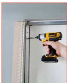
Přišroubujte dveřní rám k ostění pomocí odpovídajících šroubů
