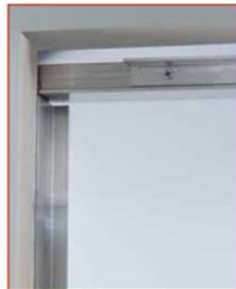
Připevněte hliníkový L-profil na nadpraží
