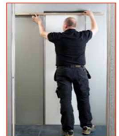
Zkontrolujte, že jsou dveře přesně v zákrytu se stěnou
