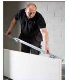
Nasadte závěsovou část na dveřní křídlo
