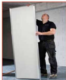
Nasadte druhou (zámkovou) část dveřního rámu
