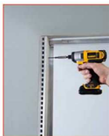
Dodělejte zakončení stěny na zadní straně zárubně podle tloušťky stěny do které je skrytá zárubeň montována
