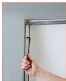
Upevněte rám pomocí seřizovacích šroubů
