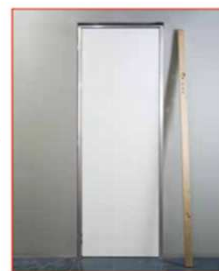
Zárubeň je připravena k omítnutí a nátěru
