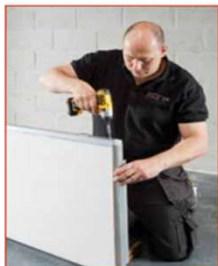
Přišroubujte nadpraží k závěsovému profilu samořezným šroubem
